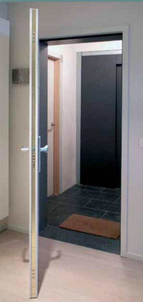
**L'huissierie** est composée de montants et de traverses, largeur 50 mm, en tôle d'acier 1.5 mm. L'ensemble est assemblé au moyen de boulons. Exécution **RF30'** : Remplie avec une mousse RF (Promafoam C ou Parafoam FR). La latte de butée est munie d'un joint en néoprène. Finition: époxyfiée, blanc (Ral 9010) ou gris métal (Ral 7037), satinée ou texturée. Profilage : type G1 (droite ) ou G2 (incliné). Epaisseur du mur: de 100 à 240 mm, adaptation possible par 10 mm.
